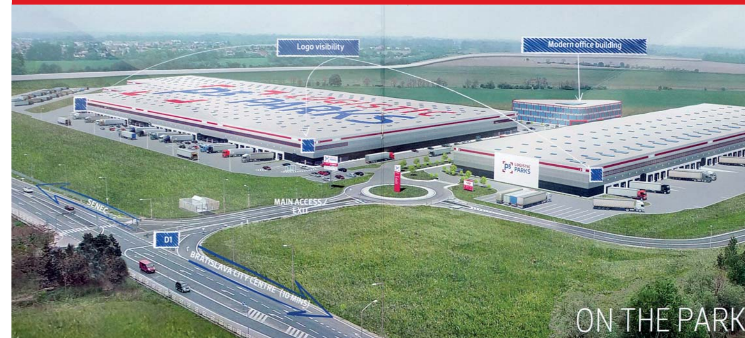
Začala sa výstavba Logistic PARKS P3
